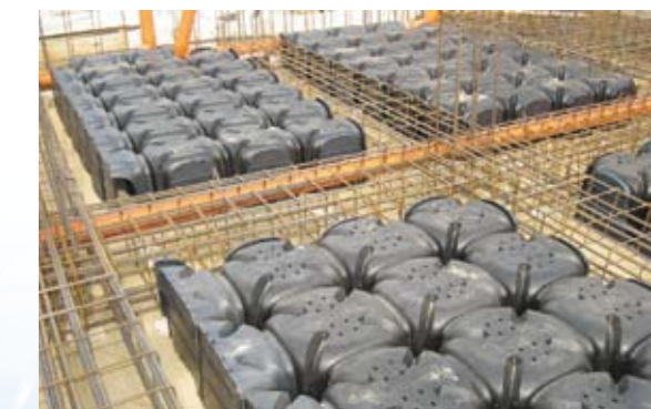
▲ UTILIZZO DEL VESPAIO AERATO MODÌ SU NUOVE COSTRUZIONI CON SOTTOFONDO DI SABBIA SILICEA
