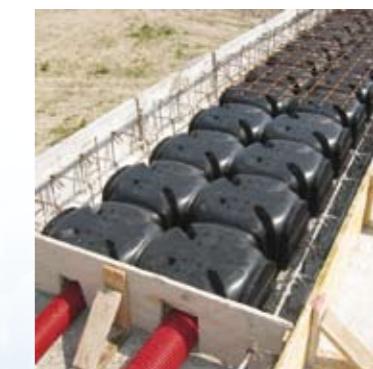
▲ UTILIZZO DEL VESPAIO AERATO MODÌ SU MARCIAPIEDI
